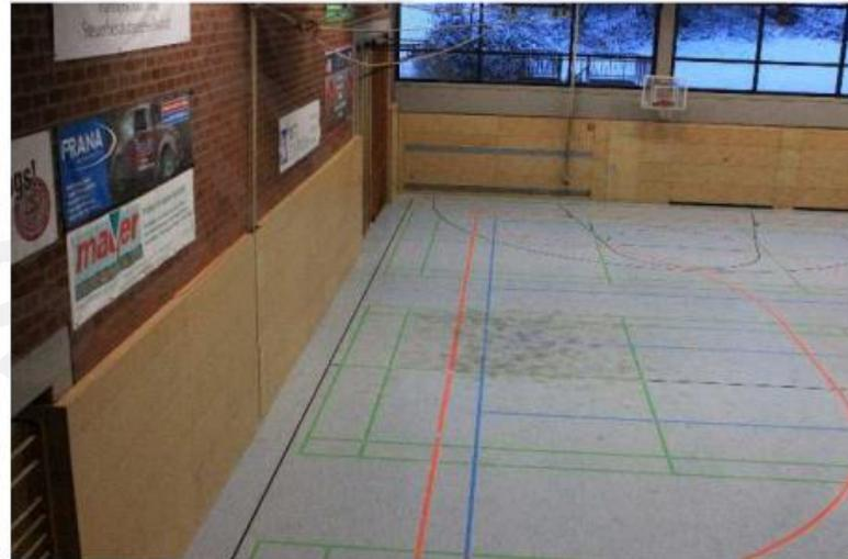
Im Bereich der Tore sind starke Verschmutzungen durch Harz sichtbar. Diese werden regelmäßig entfernt, was jedoch auch die aufgebraachte Beschichtung abnutzt. Die Beschichtung ist ca. 10 Jahre alt und muss demnach in absehbarer Zeit erneuert werden.
