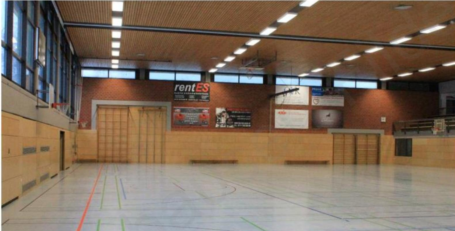
Der Prallwandbelag ist ca. 12 Jahre alt und in einem guten Zustand Die sportfunktionalen Eigenschaften sind gegeben. An den Stirnseiten sind Sprossenwände, Gitterleiter und Kletterstangen untergebracht. Diese sind aus Sicherheitsgründen während der Nutzung mit Weichbodenmatten abzudecken.
