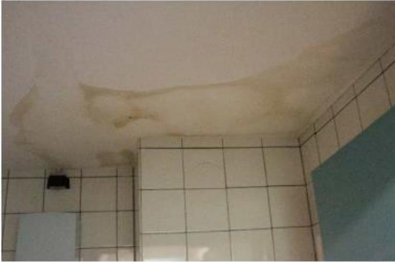
Schäden durch undichte Leitungen
