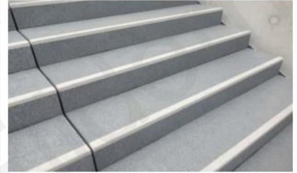
**DB-Standard** für den Bahnsteig: Betonbelag mit Natursteinvorsatz, geschliffen und glanzgestrahlt.
